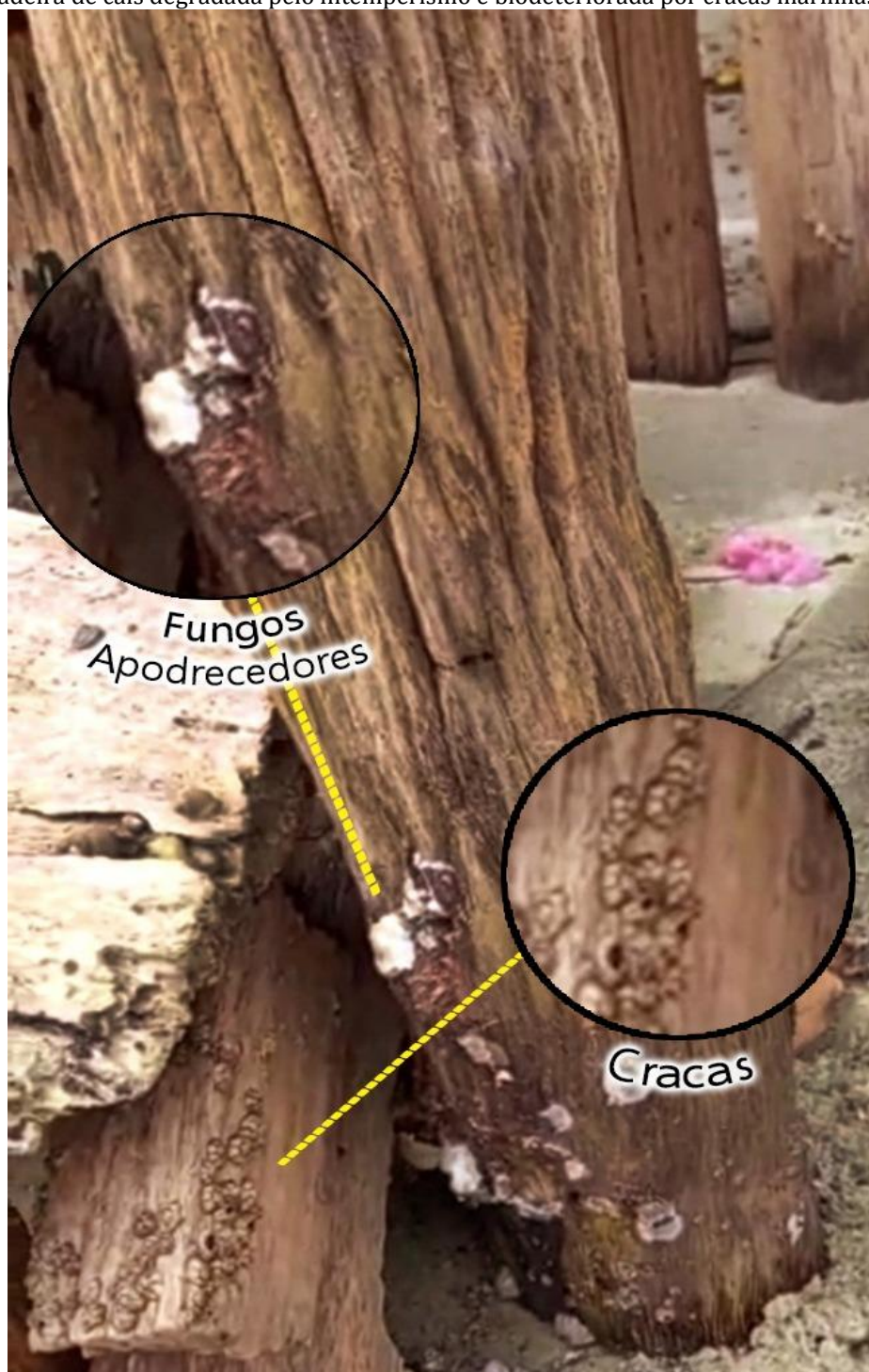
Figura 5. Madeira de cais degradada pelo intemperismo e biodeteriorada por cracas marinhas e caramujo.
